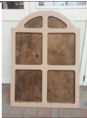
Rafforzamento telaio
